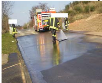
Bild 2 Nachreinigung mit einem Wasser – Tensid- Gemisch. - Gefahr der Verunreinigung im Kanalsystem u. angrenzenden Erdreich
