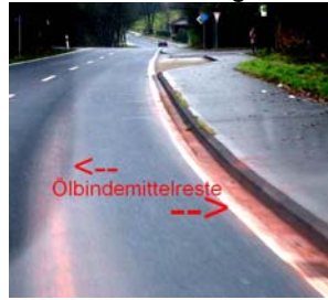
Bild 2 Nachreinigung mit einem Wasser – Tensid- Gemisch. - Gefahr der Verunreinigung im Kanalsystem u. angrenzenden Erdreich
